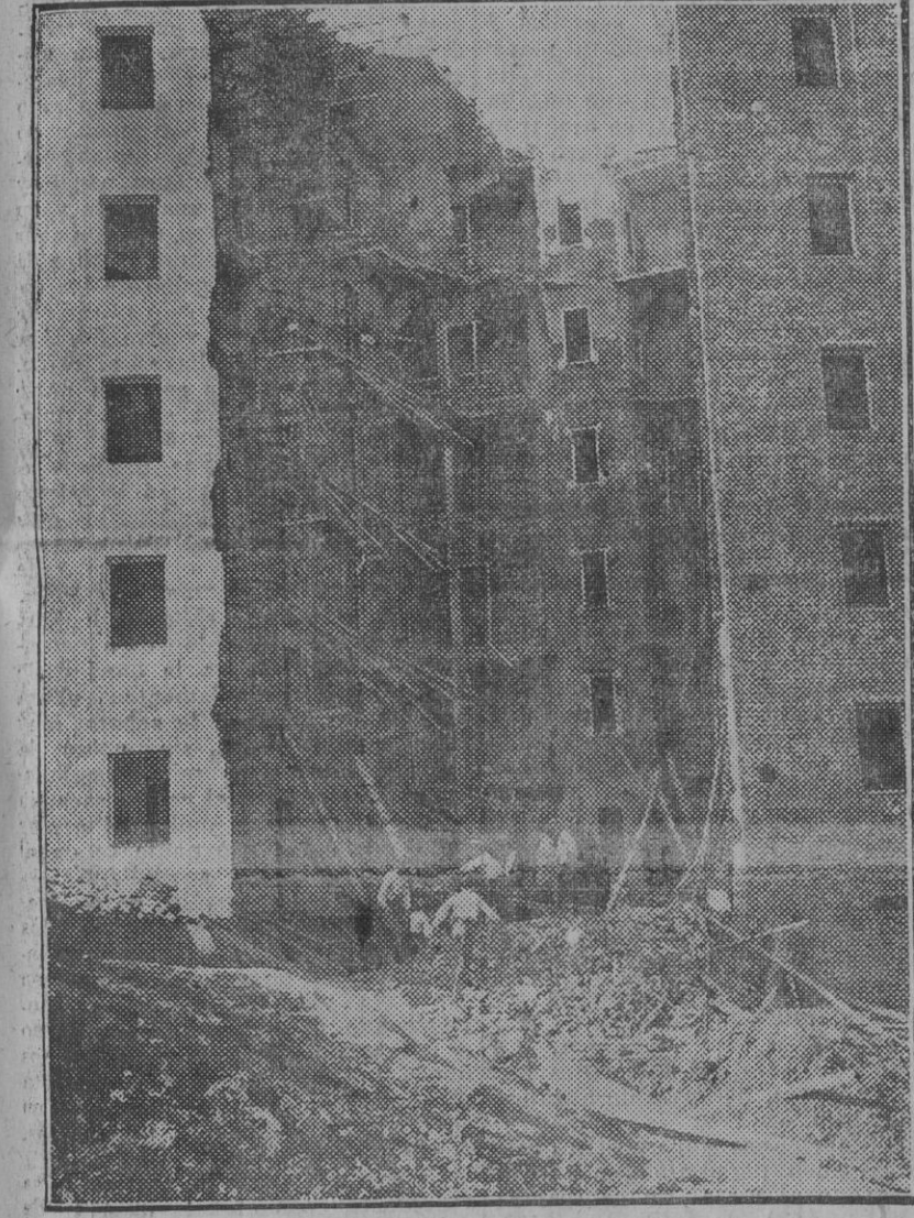
DEL HUNDIMIENTO DE AYER EN MADRID La casa número 42 de la calle Alonso Cano, que se derrumbó cuando se hallaban trabajando los obreros, causando las víctimas ya conocidas.
