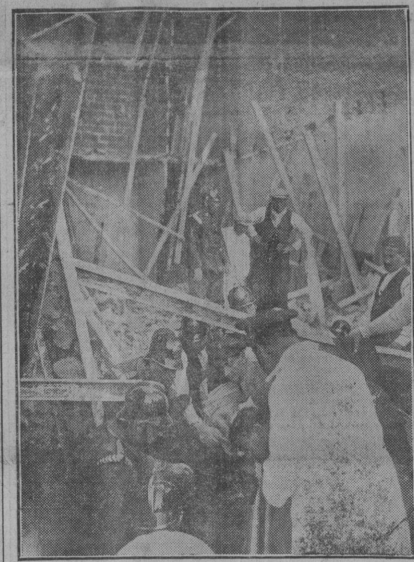
DEL HUNDIMIENTO DE AYER EN MADRID Bomberos extrayendo el cadáver de uno de los obreros que perecieron en el hundimiento.
