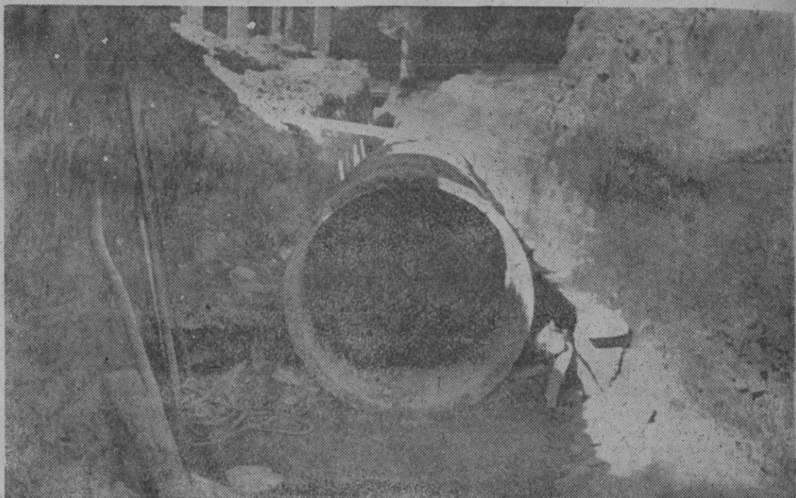
Obras de instalación de tuberías para conducciones de agua
