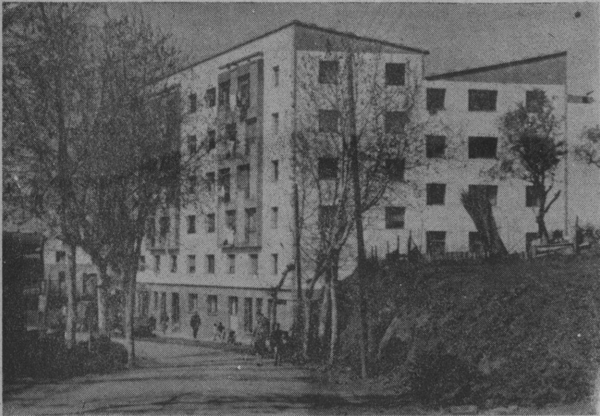
En Ripollet, la construcción de viviendas ha seguido un ritmo muy acelerado. La ciudad sigue ensanchando sus límites con magníficas construcciones como la de la fotografía.
