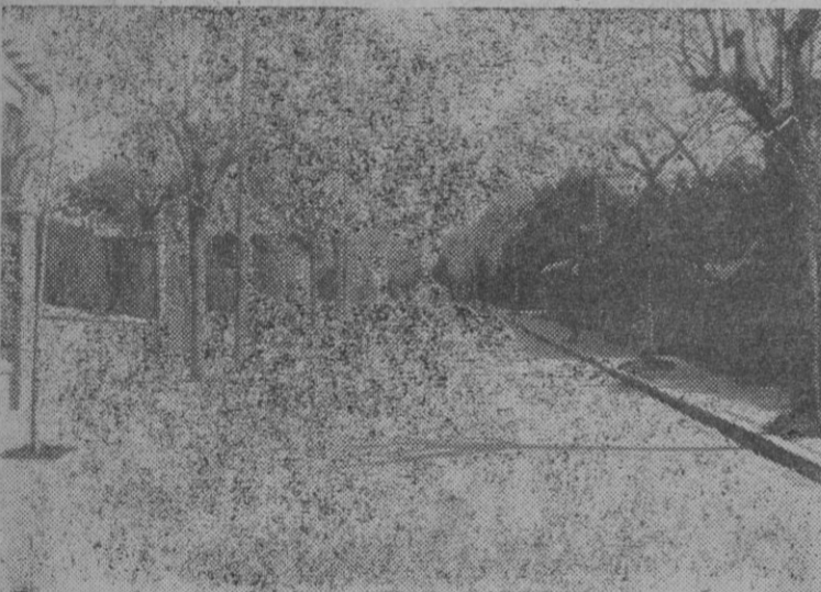
Otra Avenida de San Justo, perfectamente urbanizada
