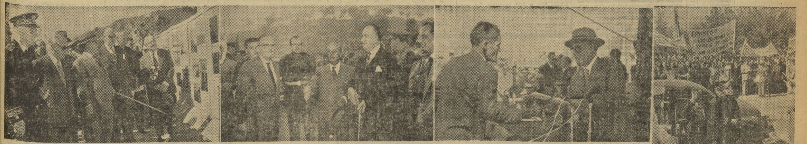
1. El Generalísimo y personalidades de su séquito durante la inauguración y bendición del pantano y central eléctrica de Cijara. — 2. Franco durante su visita a las obras en construcción de la nueva presa de Orellana, acompañado del ministro de Obras Públicas, conde de Vallellano, y otras personalidades. — 3. El Caudillo entregando los títulos de propiedad de parcelas, huertos familiares y viviendas a los beneficiarios, en Valdecazaza. — 4. Llegada de S. E. en compañía del ministro de Agricultura, señor Cavestany, al nuevo pueblo de Valdecazaza. — (Fotos Cifra)
