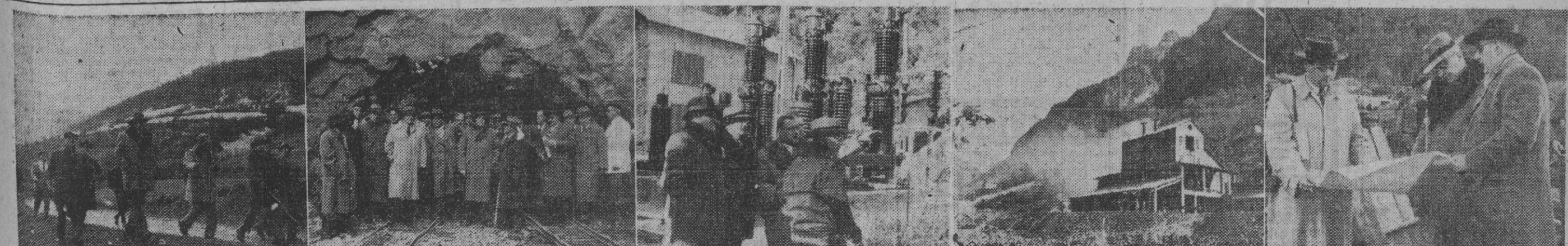
Recogemos en este repertaje gráfico varios momentos de la visita realizada por los ministros de Obras Públicas y de Industria a las más importantes obras e instalaciones de la cuenca del Ribagorzana. 1. El ministro de Industria y otros técnicos del ramo se dirigen a visitar una de sus visitas. — 2. Los ministros y acompañantes en la boca de entrada a la central subterránea de Escalas. — 3. Visitando la central de Senet. — 4. En las minas de Cierpo. — 5. El señor Planell examinando unos planos en la central en construcción de Vilallés. — (Fotos Pérez de Rozas)
