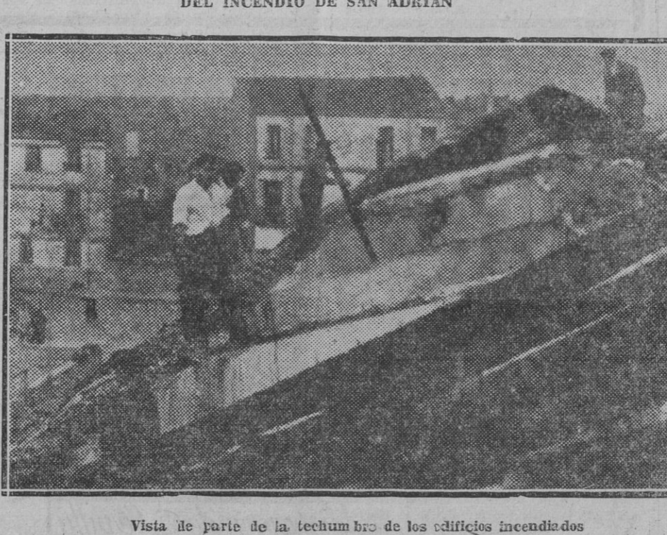
Vista de parte de la techumbre de los edificios incendiados
