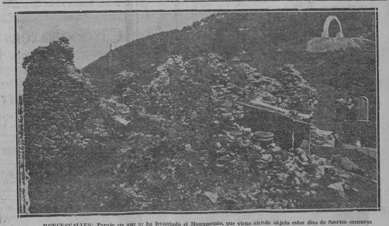
RONCESVALLES: Paraje en que se ha levantado el Monumento, que viene siendo objeto estos días de fuertes censuras
