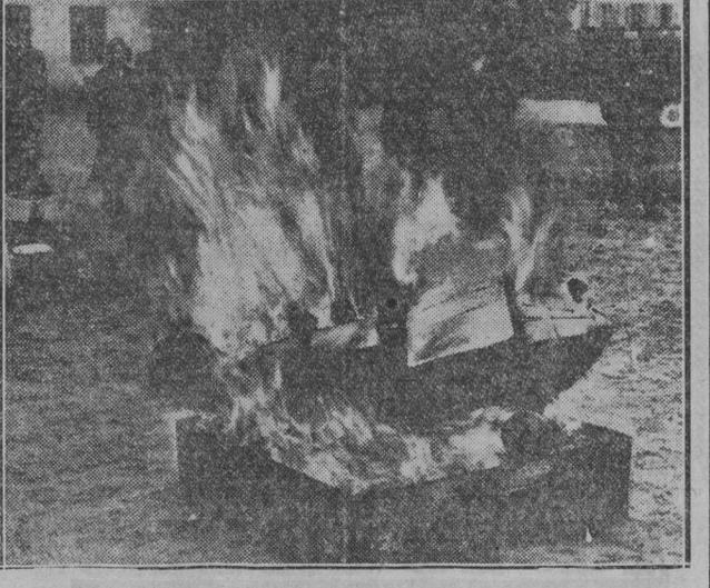
En Francia se llevan a cabo numerosos ensayos, uno de los cuales se reproduce en la foto, para conseguir la incombustibilidad del material empleado en los aviones, con lo que se evitara la causa principal de las catástrofes de aviación
