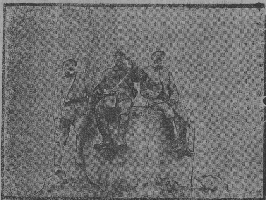
Telefonistas ingleses instalados en un antiguo abrigo alemán.
