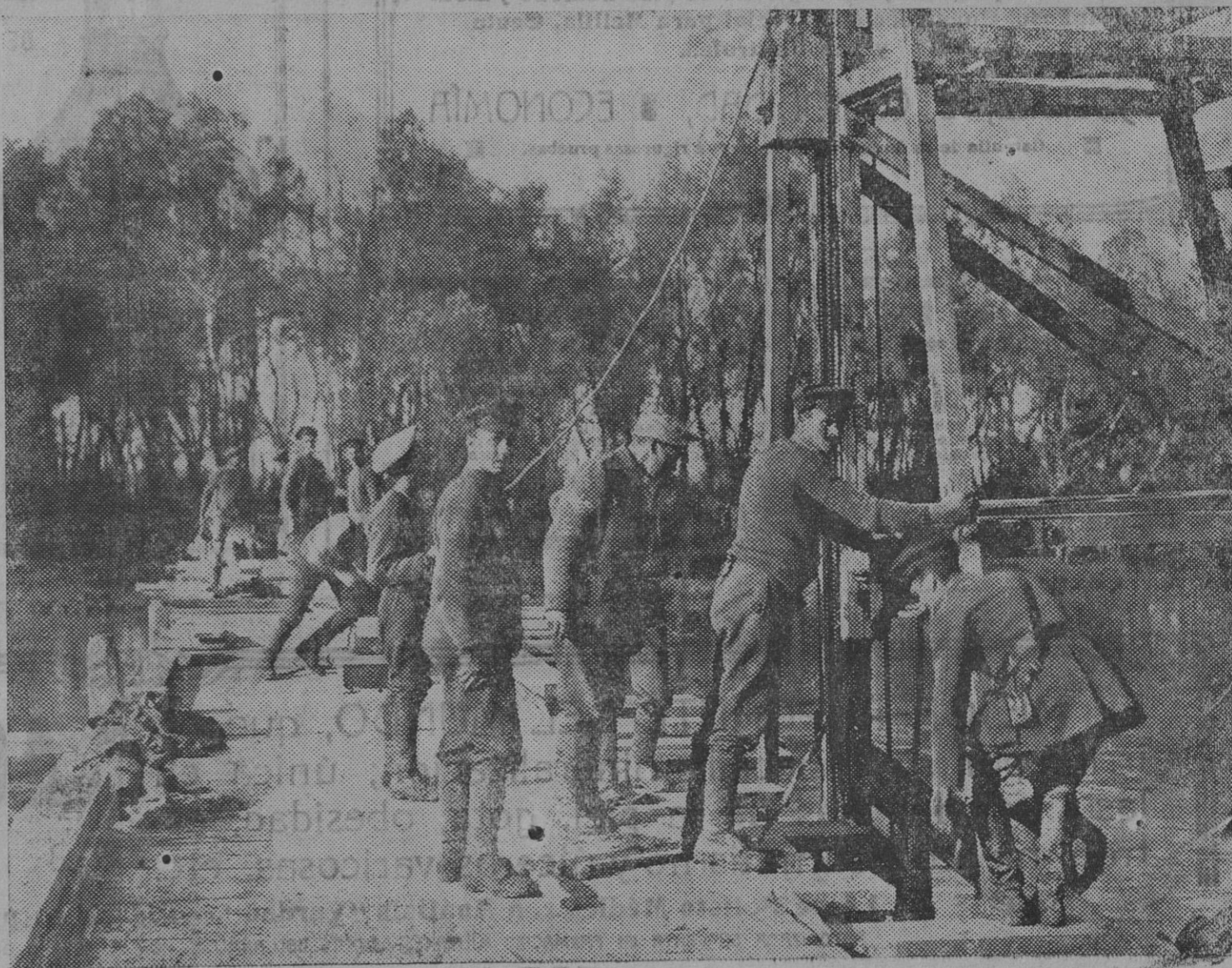
ESCENAS DE LA GUERRA.—Soldados ingleses construyendo un puente.
