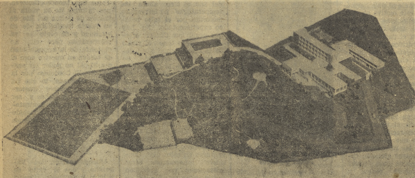
El edificio e Instalaciones de la Colonia Infantil que la Caja de Ahorros y Monte de Piedad de Cáceres ha construido en Montánchez, se nos ofrece en esta fotografía. En una zona extensa, de cerca de cincuenta mil metros, que en su día fueron donados a la Caja por el Ayuntamiento de Montánchez, se sitúa la Colonia, con capacidad para 320 niños en la temporada veraniega que este año comenzará. Una Obra de Protección al Niño, en la que la Caja tiene depositados sus mejores esfuerzos.
