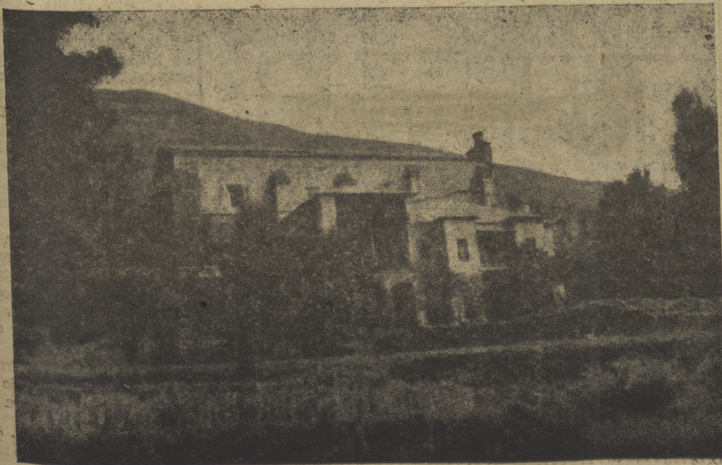
Ultima morada del César Carlos I, entregada de nuevo a la Orden Jerónima en 1958 después de la restauración realizada en el mismo
