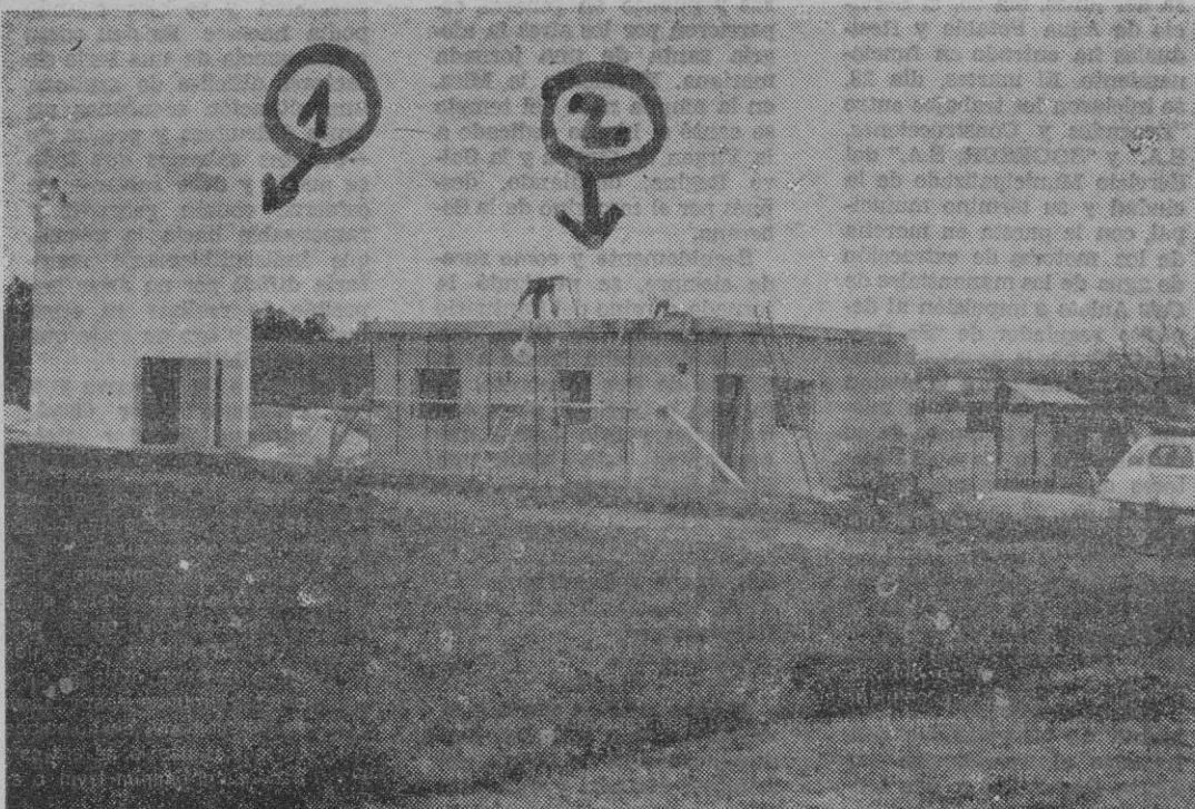
Ya ha sido alzado el transformador de electricidad que alimentara la instalacion electrica de la Estacion Depuradora. En la fotografia podemos observar (2) otro edificio que constituye la casa del guarda y el laboratorio de analisis para tener siempre controlado el proceso de depuracion. Es cuestion de tiempo... pero menos, al parecer.
