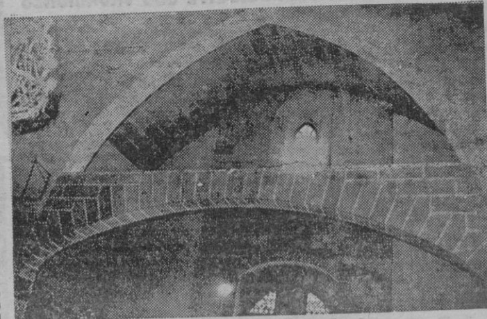
Interior de la iglesia, donde anteriormente estaba el «coro» y que el pasado día de la Inmaculada se derrumbó.
