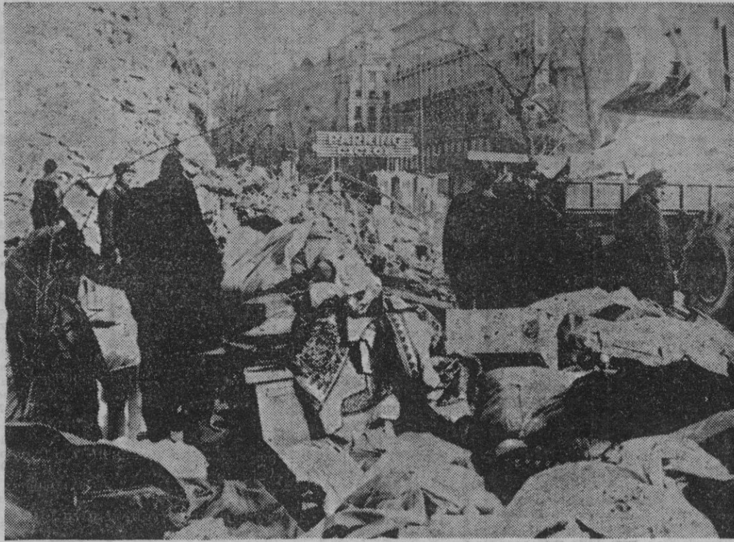
BUCAREST. — Este es un aspecto parcial de la avenida principal de la capital rumana, en la que se observan los devastadores efectos del terremoto registrado el pasado día 4 y cuyo epicentro se localizó en Rumanía. — (Telefoto Cifra Gráfica).
