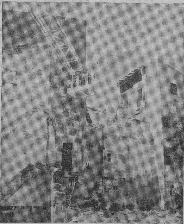
OBRAS EN EL PUIG DE SANT PERE. UNA PELIAGUDA CUESTION MUNICIPAL QUE AUN COLEA.
