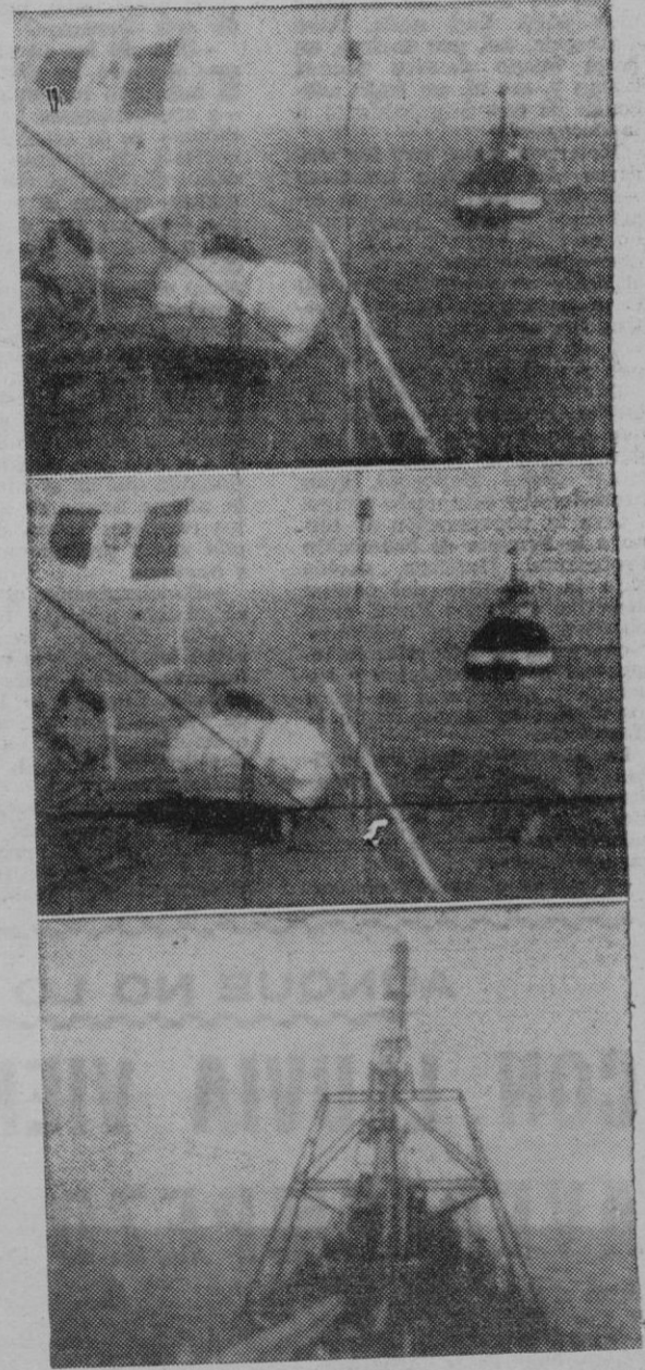
MOMENTOS DEL TENDIDO DEL PRIMER CABLE SUBMARINO PARA CONDUCCION DE ELECTRICIDAD EN ESPAÑA, A CARGO DE UN BUQUE ITALIANO ESPECIALIZADO EN ESTA CLASE DE TRABAJOS.
