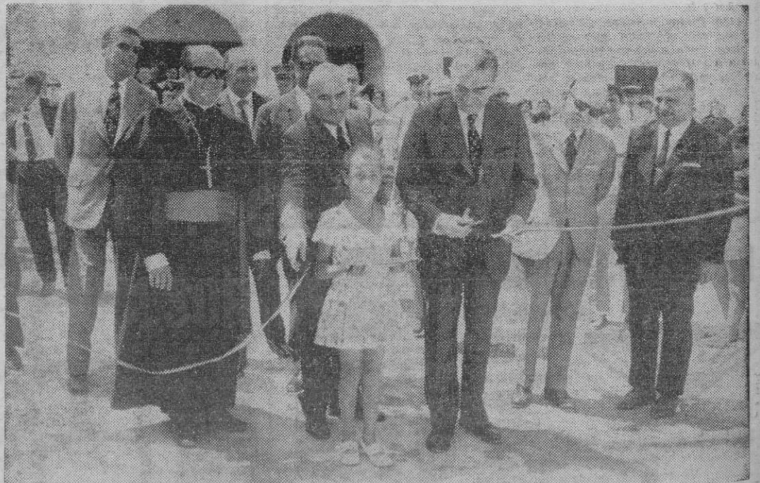
CORTE DE LA CINTA DE LAS NUEVAS CALLES ASFALTADAS EN PUIG D'EN VALLS.
