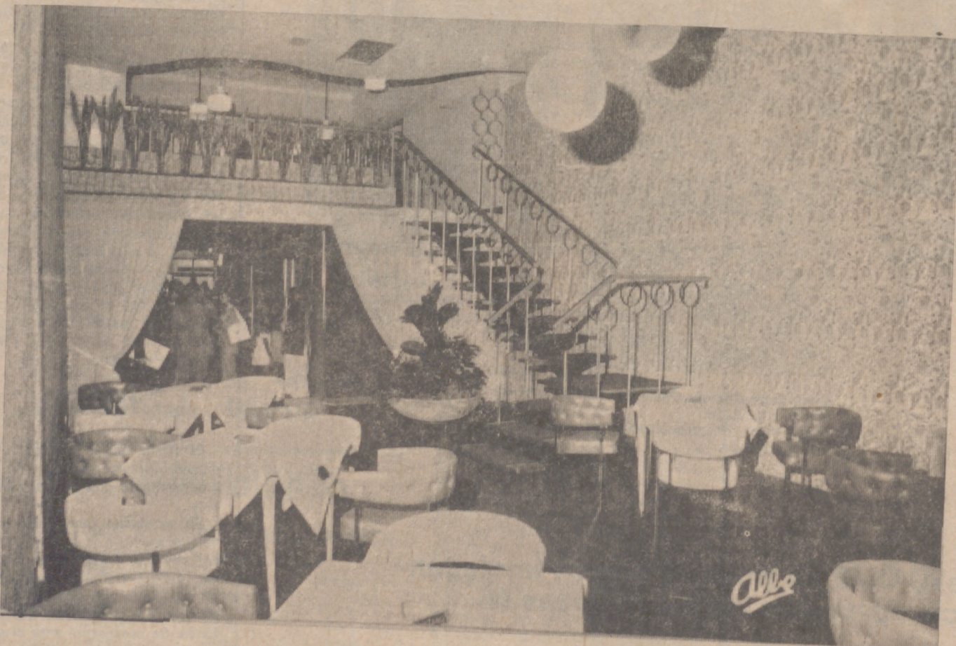
Un aspecto de la magnífica instalación de esta nueva CAFETERIA
