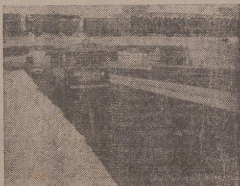
En un tramo de 150 metros de una calle de Odense se han instalado tubos de plástico a través de los cuales se arrojan 40 grados Celsius, que permanecen ocultos por el asfalto y que eliminan la nieve depositada sobre él. El invento parece eficaz, aunque costoso, para las pendientes. En la foto, el trozo experimental completamente libre de nieve, mientras la circulación transita por él con normalidad.—(Foto Fiel).
