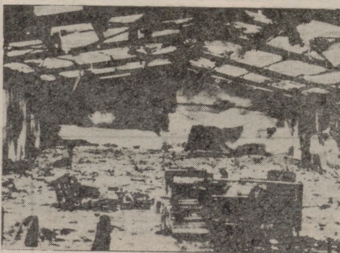
Así quedó, totalmente arrasado, uno de los talleres de la Cárcel de Málaga, como consecuencia del motín protagonizado el sábado por tres cuartas partes de la población reclusa. Una parte de los presos se amotinó, mientras el resto incendiaba colchonetas y enseres. La Prisión quedó prácticamente destruida. Pocas horas después se desencadenaban acciones similares en la Cárcel de Oviedo.
