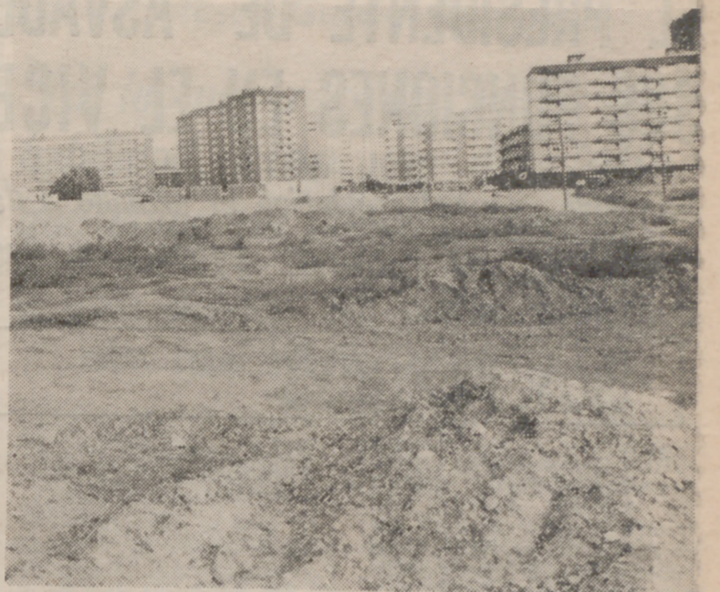
Obras de infraestructura para preparar los terrenos de la segunda fase de Huerta del Rey.
