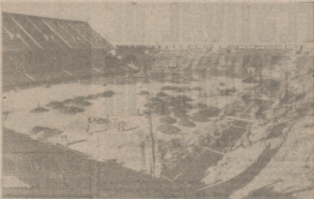
Estadio del Vélez Sarsfiel (53.000 espectadores), actualmente en obras, principalmente en lo que el terreno de juego se refiere, para su puesta a punto en el Mundial de Fútbol 1978.
