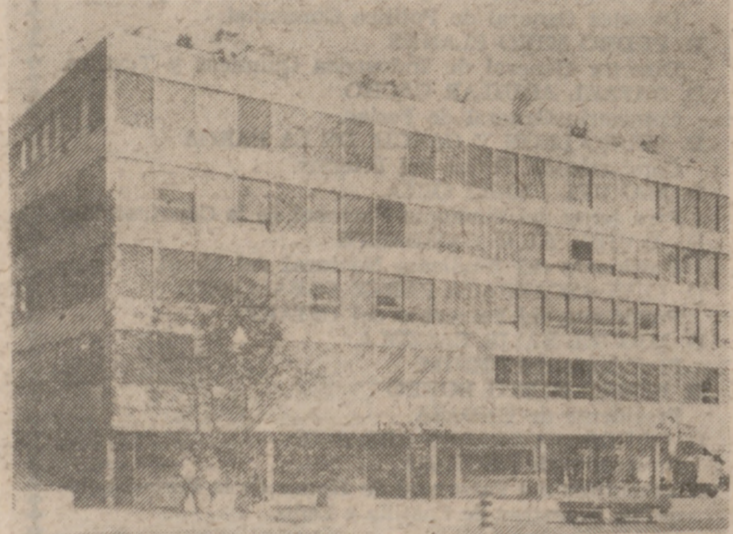
Placas de aluminio colado en fachadas.
