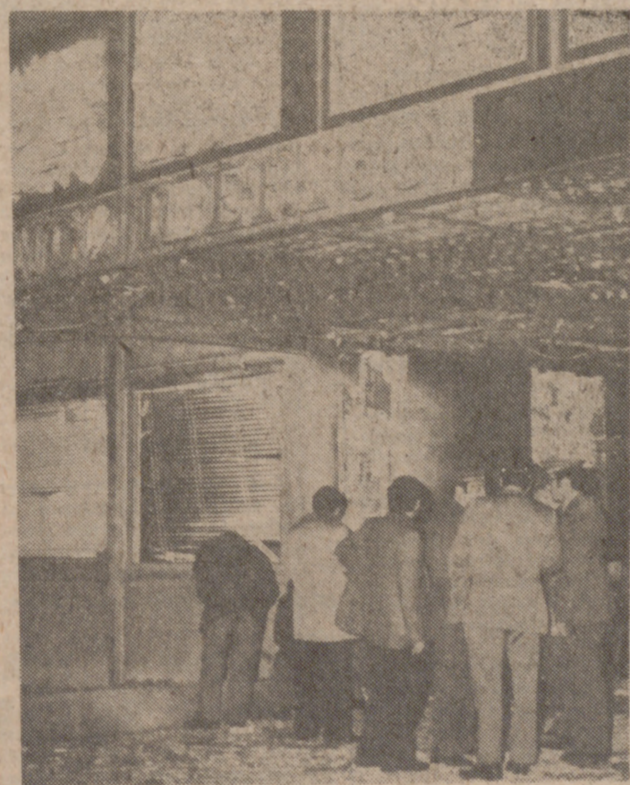
MADRID.—Una explosión, al parecer debida a un artefacto intencionadamente colocado, causó ayer daños en la estructura exterior y parte del interior del Banco Ibérico, sito en la calle de María de Molina, esquina a General Mola.
