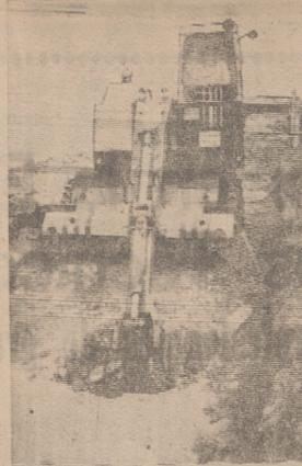
Máquina con la que se hizo el pozo. Puede perforar hasta ocho metros de profundidad
