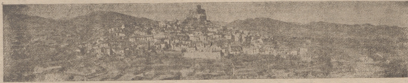
VISTA GENERAL DE CORNAGO
