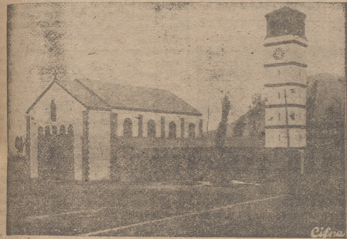
Iglesia Parroquial de las Carreras, que ha sido construida de nueva planta en lugar más céntrico que se encontraba la destruida.
