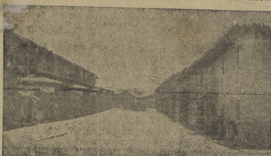
Una de las calles del nuevo San Leonardo, que avanza rápidamente a su total reconstrucción.
