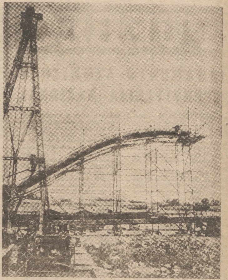
GASODUCTO DE LACQ. —Una vista de las tuberías que conducen el gas natural desde Lacq (Bajos Pirineos) a París. Los tubos que vemos aquí son alzados para salvar el río Sena en Montreaux. Semajantes a éstos serán los del gasoducto que traerá el gas natural de Mostaganem a Cartagena para llevarlo, a través de España, hasta Estrasburgo
