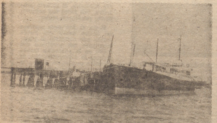
El barco inglés «Methane Pioneer», especialmente equipado para el transporte de gas natural en estado líquido, a 160 grados bajo cero. Lo vemos aquí atracado en Canvey Island (Essex, Inglaterra) al final de uno de sus viajes desde los Estados Unidos
