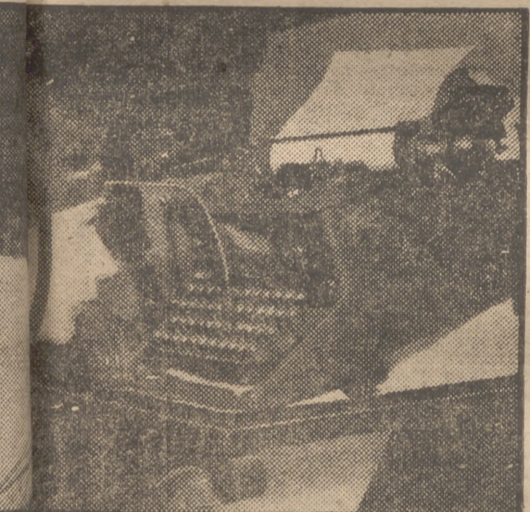
El Hall de Londres se celebró una Exposición por el Consejo Central de Ayuda a los Inválidos. Aquí ofrecemos un detalle del aparato que hace escribir a máquina sin manos.
