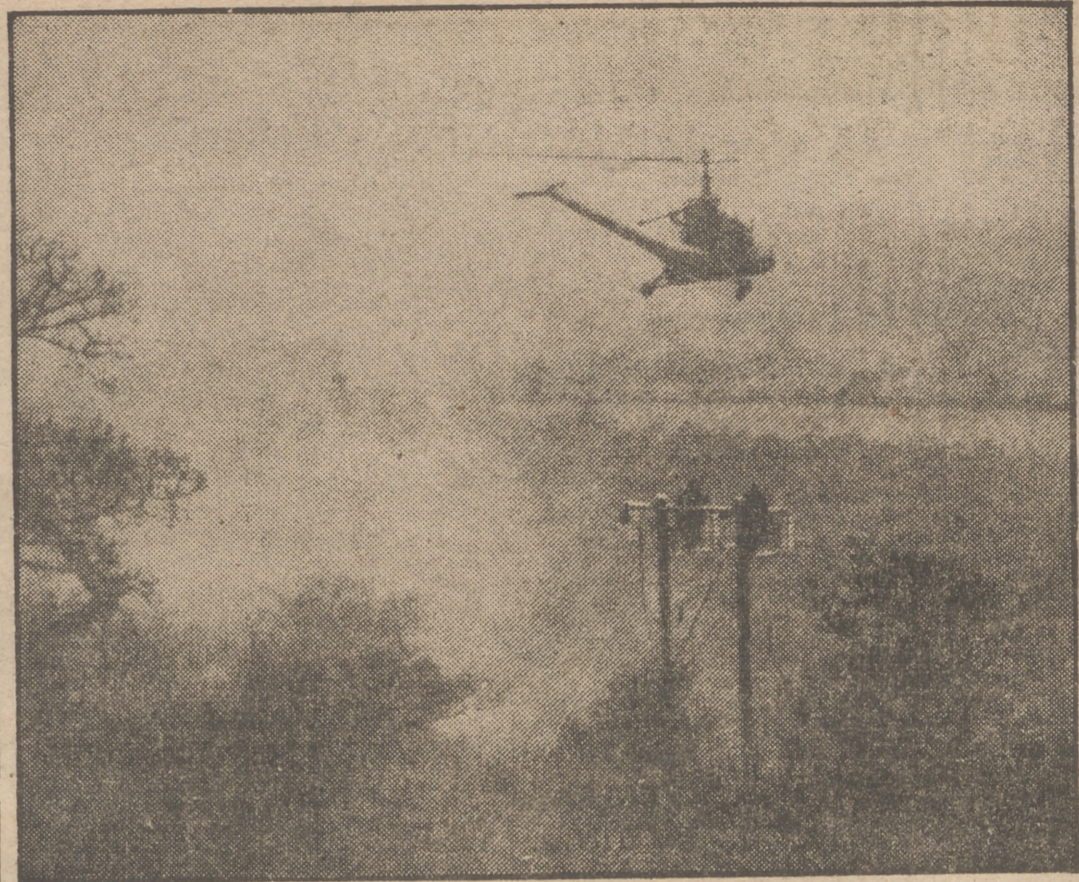
Por primera vez ha sido utilizado con gran éxito el autogiro para el tendido de una línea de conducción eléctrica sobre un valle. Aparte del tiempo y trabajo ganados, se ha logrado salvar a numerosos árboles, que hubieran tenido que ser cortados. La operación se ha realizado en Malvern Hills (Worcester). (Foto Gifra.)
