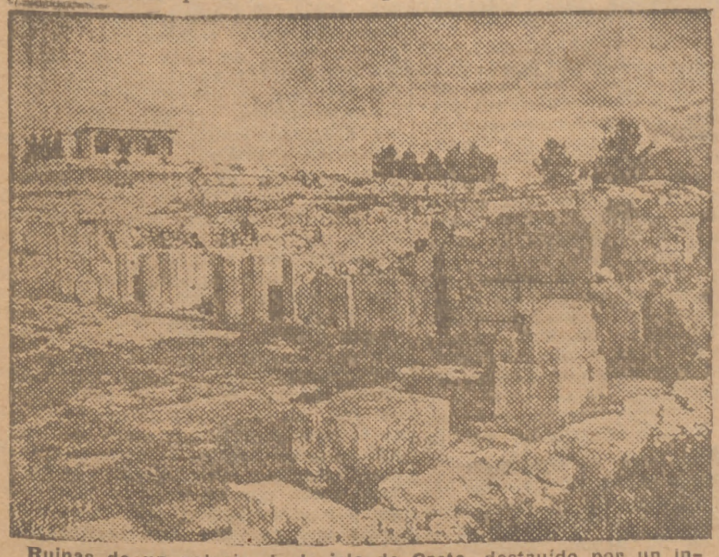
Ruinas de un palacio de la isla de Creta, destruido por un incendio. El edificio, de alabastro en su totalidad, databa del siglo IV antes de Jesucristo. (Foto A.)
