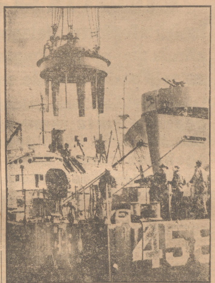
En el barco de guerra "L. S. M.-458", de la Marina de Estados Unidos, se han efectuado las pruebas de un nuevo modelo de hélice. La foto registra la maniobra inicial de su acoplamiento al navío. El resultado de la hélice cicloidal ha sido magnífico, demostrando que con ella se simplifican las maniobras. La hélice consta de seis paletas, cada una de las cuales tiene giro autónomo al mismo tiempo que el conjunto rotor. (Foto A. P.)
