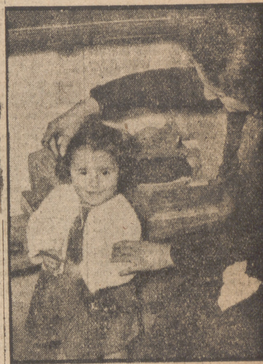
Salvada del incendio
