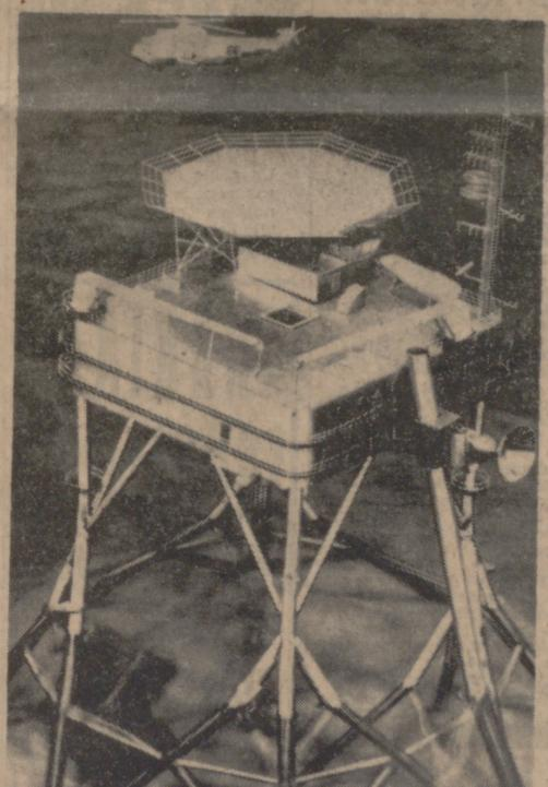
Este año se construirá en el Mar del Norte una isla artificial de 60 metros de altura destinada exclusivamente a la investigación. A una profundidad de 32 metros, la estación de investigación —nuestra fotografía— será erigida sobre fundamentos de cemento armado de 12.000 toneladas de peso, así como la base de tubos de acero.
