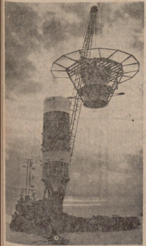
Helsinki. Foto captada a lo largo del Golfo de Finlandia. Se realizan los últimos trabajos de ajuste para el nuevo faro y estación meteorológica en la parte norte del Golfo. Comenzará a funcionar este invierno. Pesa unas mil toneladas y se eleva 26,35 metros sobre la superficie del Océano. (Telefoto Cifra G-Upl.)
