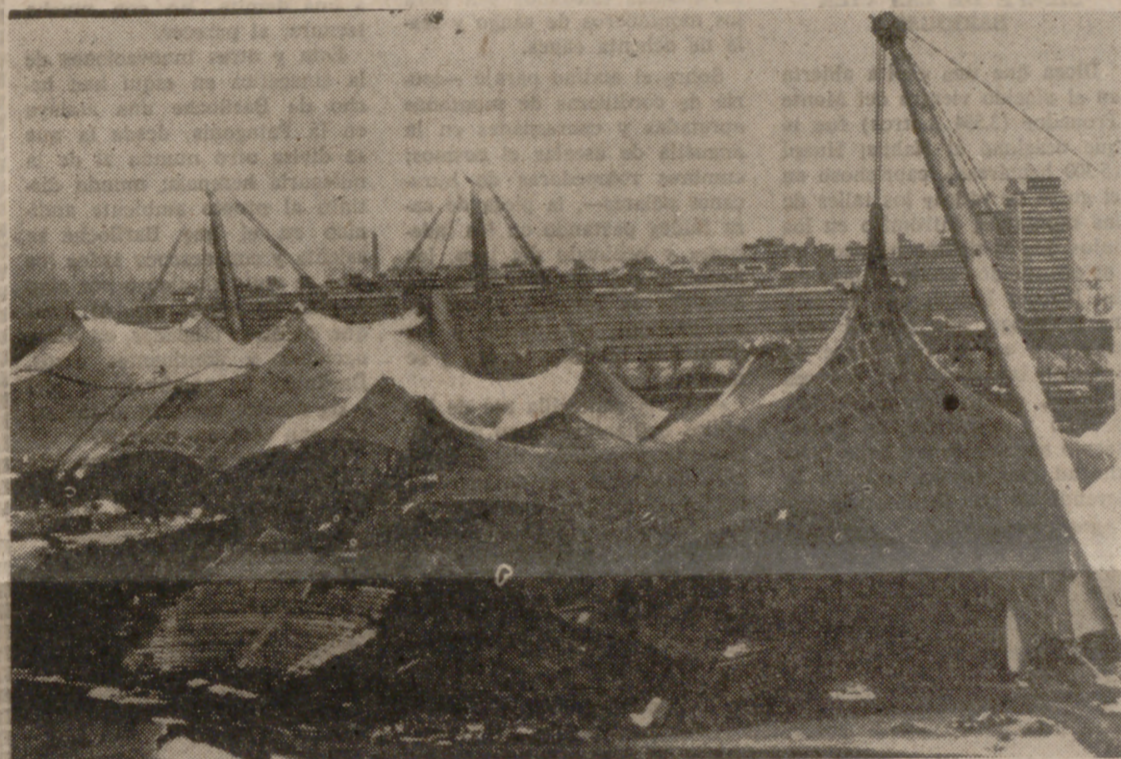
Las instalaciones olímpicas, fruto de una arquitectura audaz. (Foto PYRESA.)
