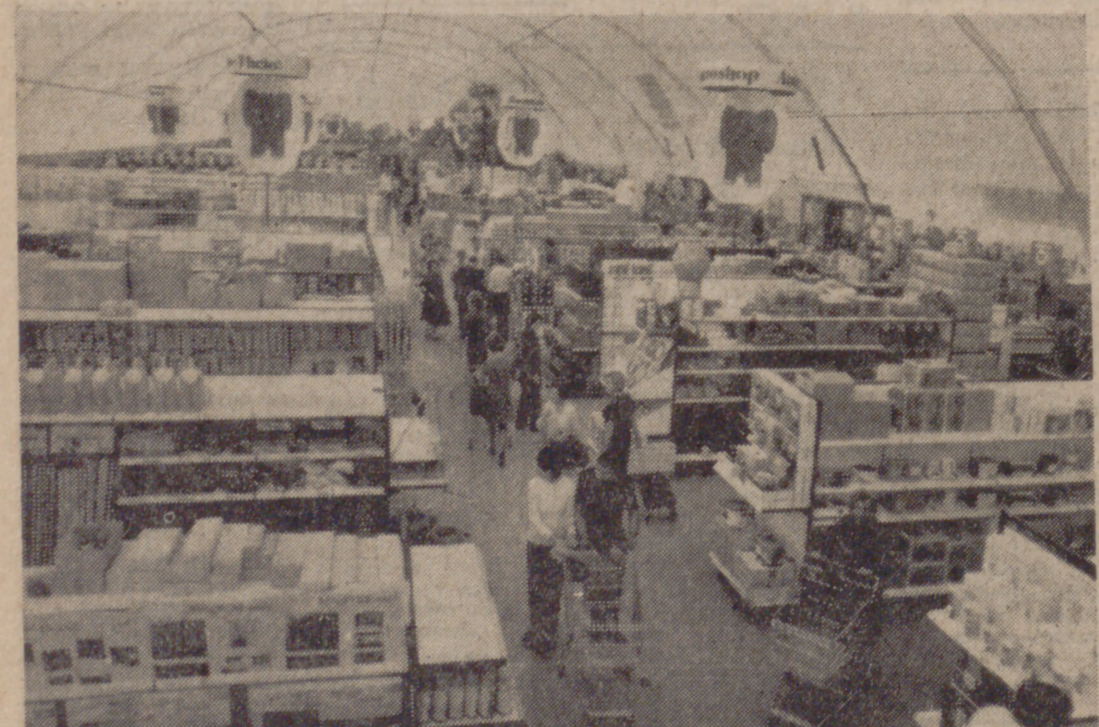
ESSEN.—Acaban de abrir en Zurich unos grandes almacenes cuya cubierta es una nave neumática. La “piel” de dicha nave se mantiene tirante con una pequeña presión de aire. Gigantescas máquinas de coser han relevado a las hormigoneras.
