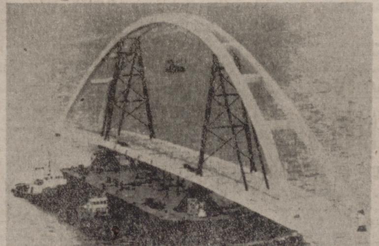
CHIRA (Japón).—En la foto, un remolcador arrastra una gran plataforma con un puente de 850 toneladas desde el puerto de Ichikawa al puerto de Toba, 200 millas al suroeste de Tokio. El puente tiene 195 metros de largo y 8,25 de ancho y será instalado en una autopista cerca de Toba.—(Telefoto Cifra Gráfica-Upi.)
