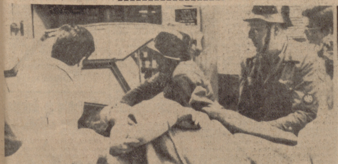
BARCELONA.—Un edificio de cuatro plantas se ha hundido parcialmente, causando nueve —por lo menos— muertos y heridos. Al parecer, el siniestro ocurrió por unas obras de un aparcamiento que se efectuaba en la parte baja del edificio, y que al fallar las columnas de soporte arrastró a los cuatro pisos. En la foto, un momento del rescate de las víctimas.—(Foto Cifra.)
