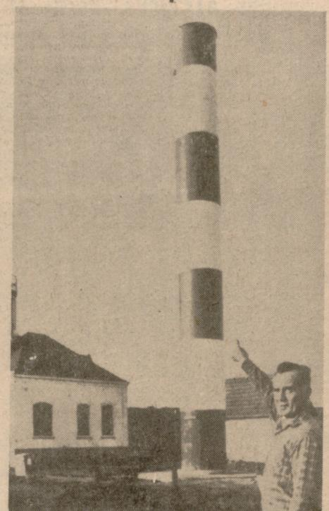
Es éste el primer faro de plástico del mundo. Pesa sólo cinco toneladas, mientras que su antecesor, situado a orillas del Elba, al noroeste de Hamburgo, y construido de hormigón y ladrillos, tiene un peso ocho veces mayor...
