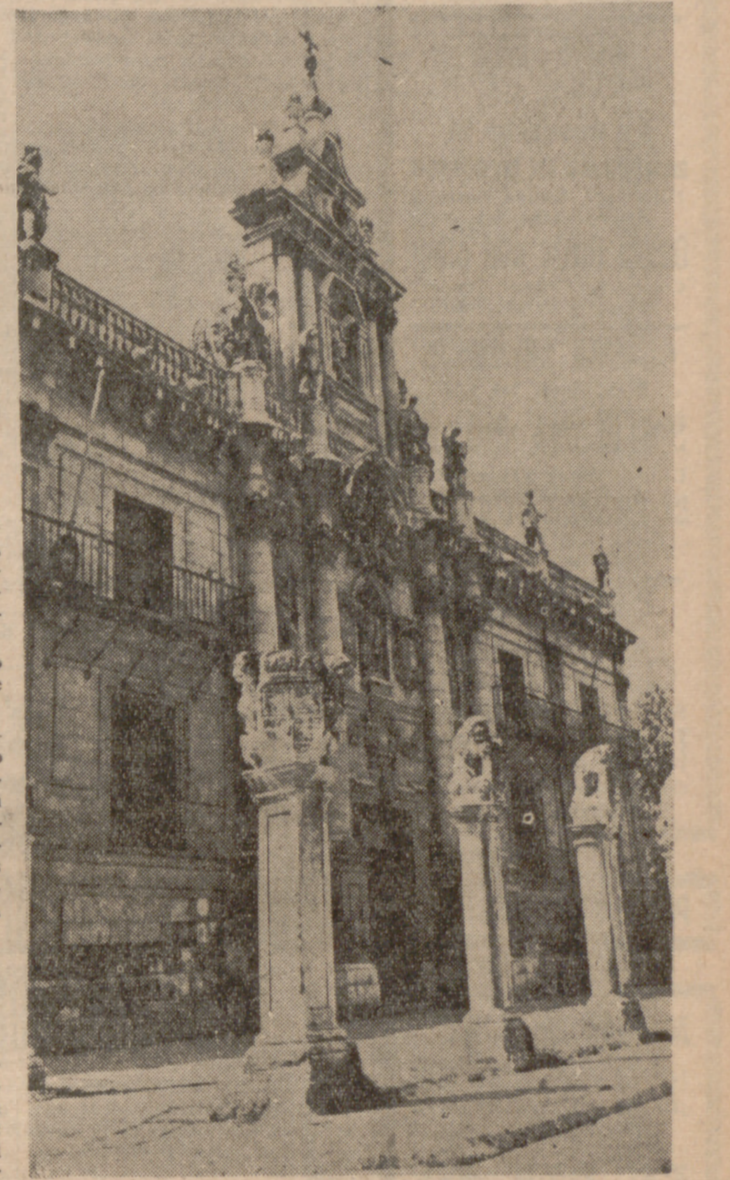
Fachada de la Universidad. El viejo edificio quedará exclusivamente para las Facultades de Derecho y Letras. Será objeto de grandes reformas para la instalación de magníficos Seminarios al servicio de los cursos de especialización.
