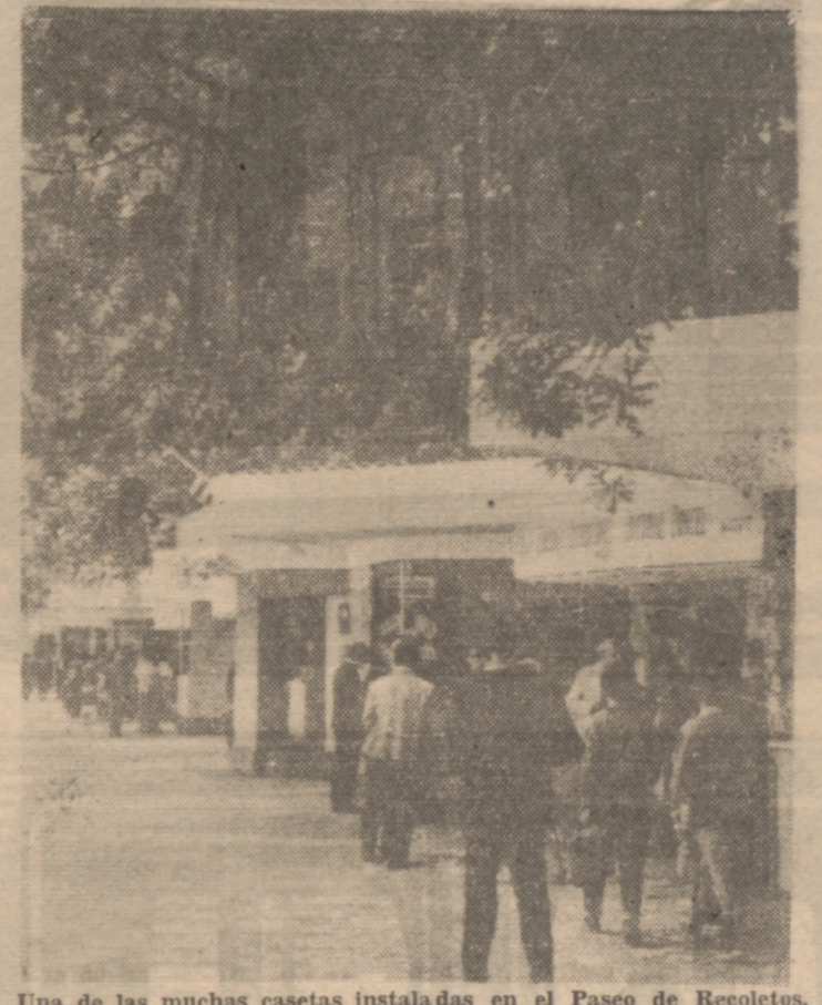
Una de las muchas casetas instaladas en el Paseo de Recoletos.
