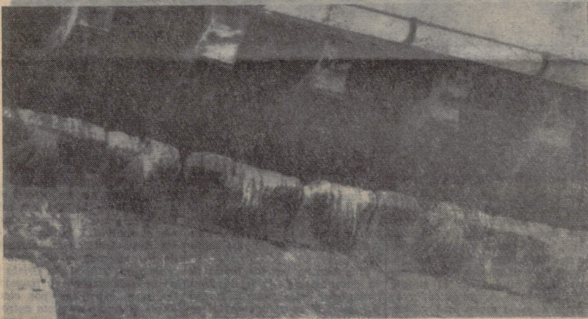
Cornisamento de vietras, testimonio jacobino en el ábside de la iglesia de Santiago, debajo de los cancelillos del alero.
