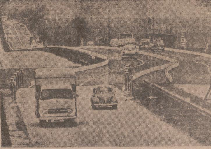
Un equipo de técnicos de la firma Krupp ha instalado en veinticuatro horas el primer kilómetro de la carretera Francfort-Kassel, con cuatro caminos, dos por cada dirección. Esta carretera será realizada con planchas de acero que tienen una duración de diez años. Para el primer kilómetro se emplearon quinientas, con un peso total de dos mil toneladas.—(Europa-Press.)
