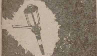
EN 1879 COMENZÓ A HACER EXPERIMENTOS CON LA ILUMINACION ELECTRICA. BUSCANDO UN FILAMENTO QUE ARDIESE AL ROJO BLANCO. DURANTE HORAS DENTRO DE UN RECIPENTE VACIO. POR FIN EL 21 DE OCTUBRE DE 1879, FABRICO UNA LAMPARA CON UN FILAMENTO DE ALGODON QUE ARDIO DURANTE 40 HORAS. ERA LA PRIMERA DEMOSTRACION DEL ALUMBRADO ELECTRICO.
