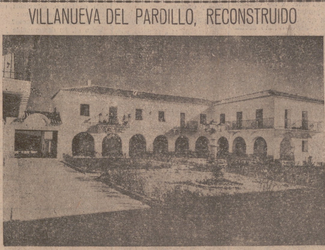
VILLANUEVA DEL PARDILLO, RECONSTRUIDO Una vista de la plaza principal del pueblo con las nuevas viviendas, que ha sido reconstruido por la Dirección General de Regiones Devastadas, dependiente del Ministerio de la Gobernación.—(Foto Cifra-Gráfica)
