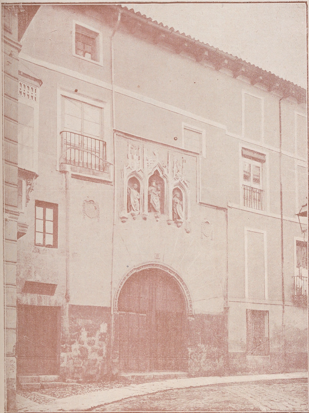
PUERTA DE ENTRADA AL PATIO DE EL ROSARILLO
