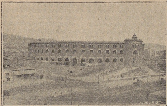
Vista de la plaza de toros «Las Arenas»
