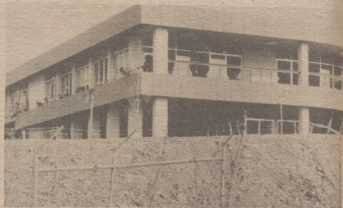
LISBOA.— Daños causados por una misteriosa explosión en la sede de la NATO en Lisboa que quedó prácticamente sin cristales.— Foto Ap-Europa Press
