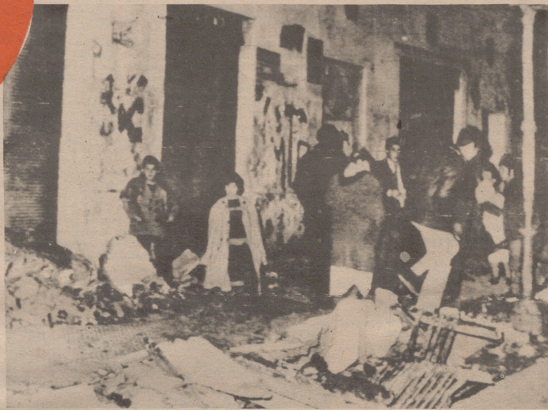
SANTAGO DE CHILE: El terremoto que ha asolado la capital de Chile, ha derrumbado gran parte de las fachadas de los antiguos edificios de la ciudad.
