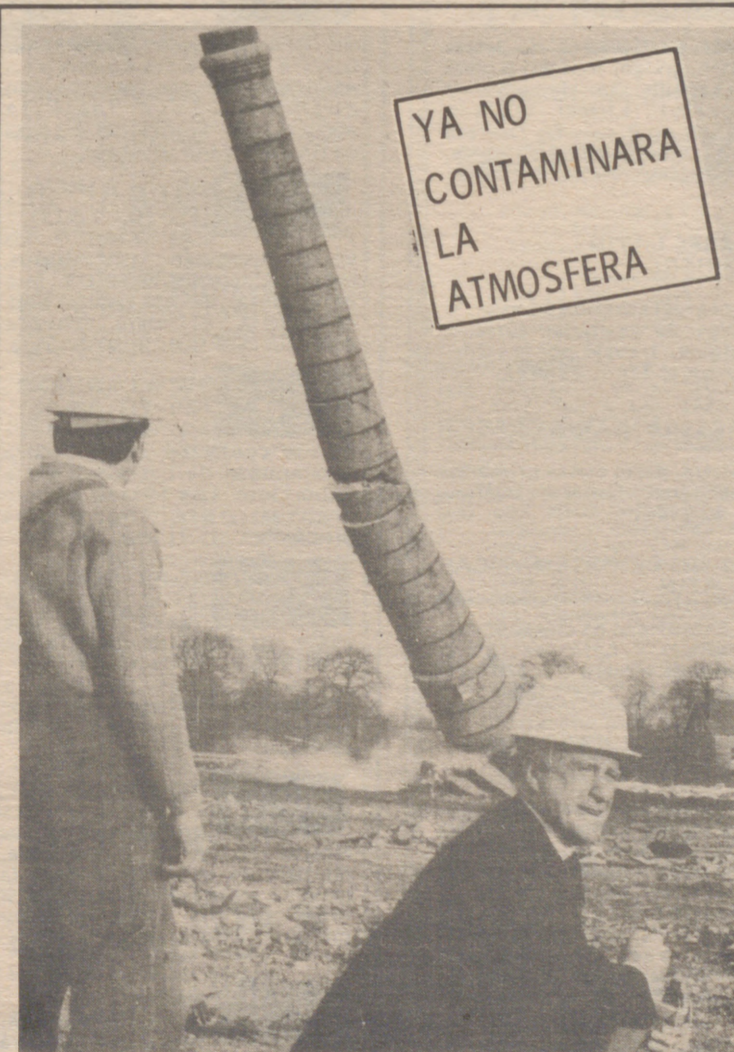
ENFIELD, Middlesex, Inglaterra. Mr. Desmond Plummer, dirigente del gran consejo de Londres, pulsando el detonador que provoca la explosión que derrumba la gran chimenea de 125 pies de altura de la antigua fábrica de calcetines de Klinger.
